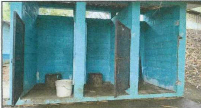
Foto 4: VISTA ACTUAL DE BAÑOS. PUERTAS, ÁREA A INTERVENIR.
