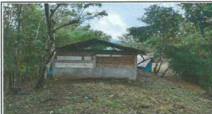
Foto 3: VISTA PANORAMICA EXTERIOR DE COCINA, ÁREA A INTERVENIR.
